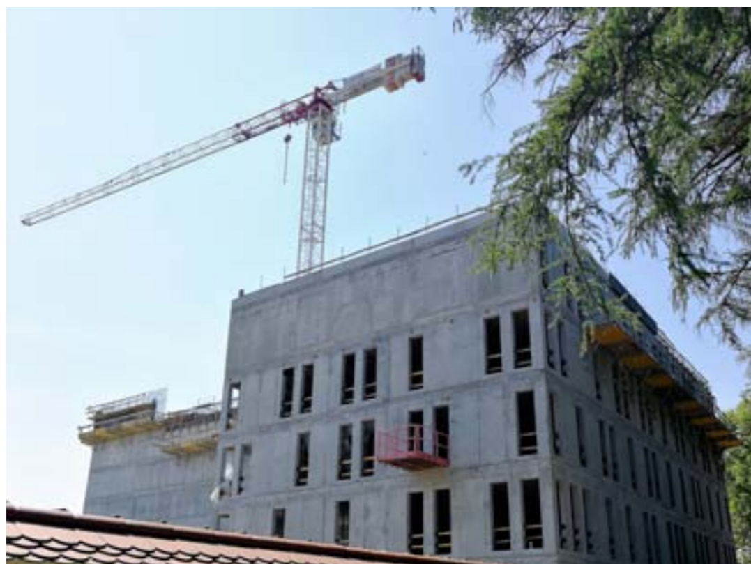
Fasada budynku biurowego Archiwum-widok od strony północno- wschodniej (fot. ECM Group Polska S.A. - administrator budowy)
